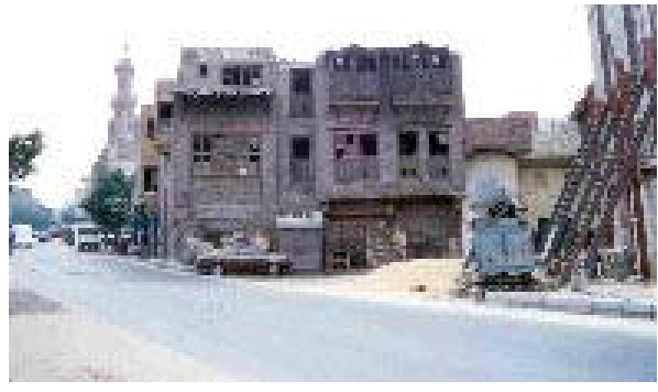
شكل (١) فرض شوارع عريضة في قلب النسيج التقليدي للمدينة القديمة سبب أضرارا بالغة، بالإضافة إلى التخریب والهجر الذي لحق بالمباني التاريخية، والصورة لسبيل وكتاب بحي القلعة بالقاهرة [٨] .
